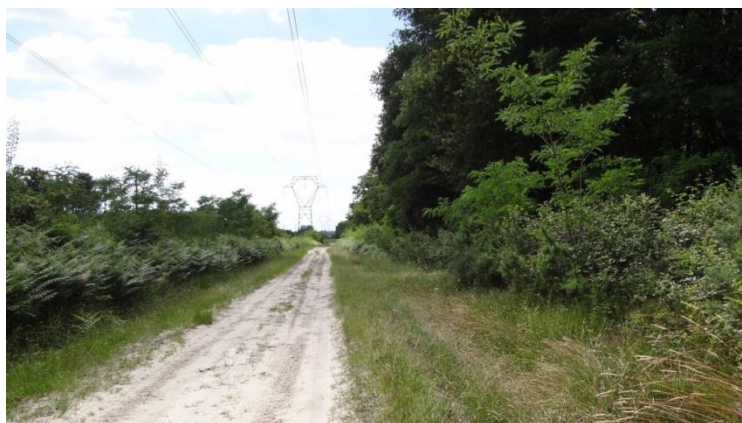
La piste dans la tranchée déboisée
