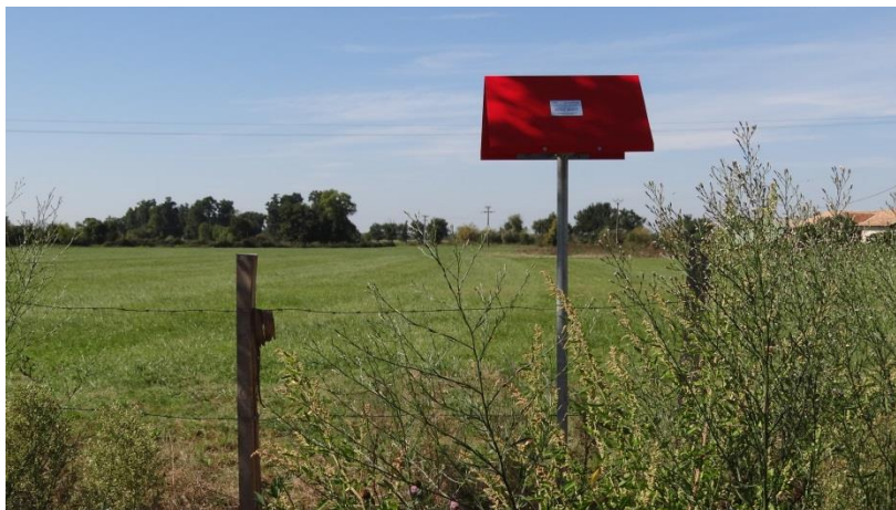
Exemple de balisage d'une liaison électrique souterraine
