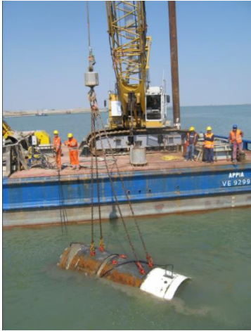
Moyens nautiques potentiellement à mettre en œuvre pour la partie marine du micro-tunnel : (à gauche) exemple d'une barge jackup légère pour récupération du micro-tunnelier* et (à droite) d'un navire câblé. (Source : Sea Outfall – ICOP)
