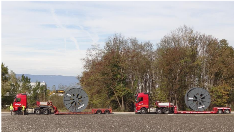
Camions de livraison de tourets de câbles en attente de livraison sur le chantier de la station de conversion du projet Savoie - Piémont
