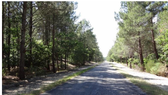
La route de la Cantine Nord
