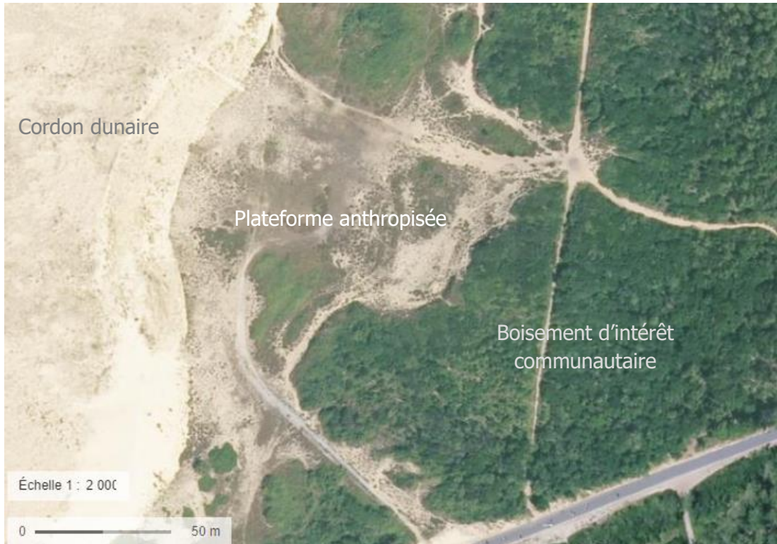
La zone d'implantation du chantier pour le passage en sous-œuvre* sous la dune
