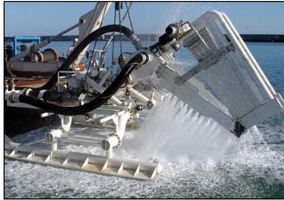
Exemple de jetting*
