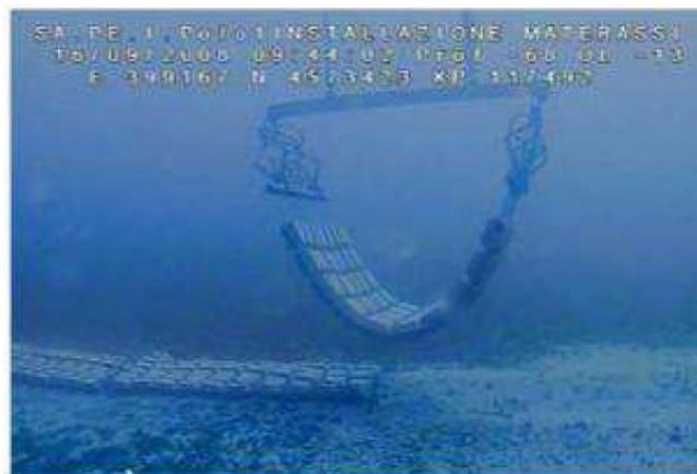
Photo de la pose d'un matelas béton sur un câble sous-marin
