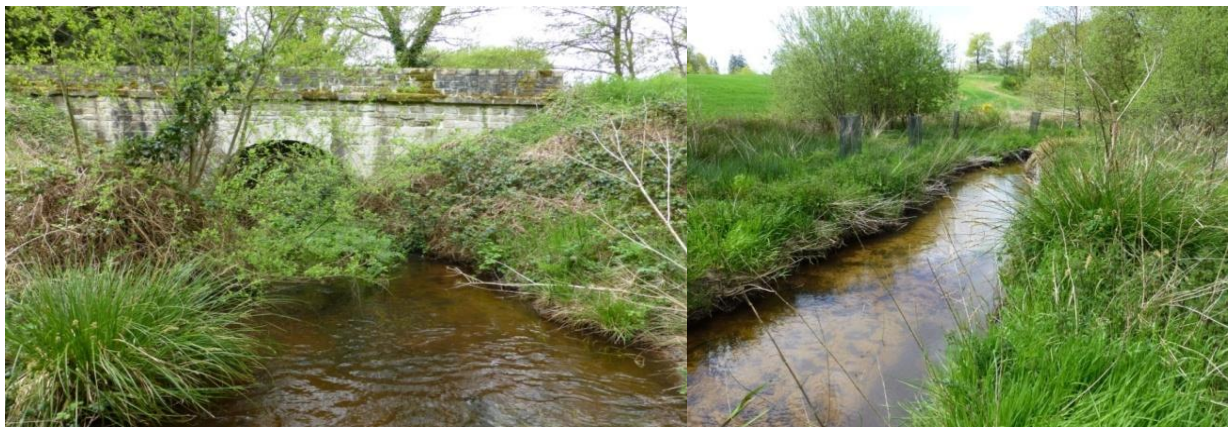
Exemples de cours d'eau franchis en ensouillage quelques années après les travaux
