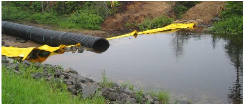
Exemples de travaux de franchissement de cours d'eau en ensouillage
