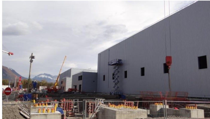
Le chantier de la station de conversion de l'interconnexion Savoie - Piémont
