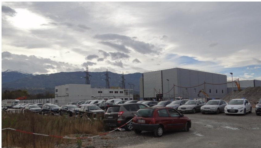
Le parking et la base vie du chantier de la station de conversion du projet Savoie – Piémont
